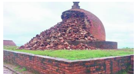
Mái vòm của Đại Bảo tháp tại di tích ở khu phức hợp Phật giáo tại Thotlakonda bị hư hại do mưa lớn
