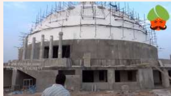
Công viên Chủ đề Di sản Phật giáo đang xây dựng tại bang Andhra Pradesh, Ấn Độ Photo: PTI
